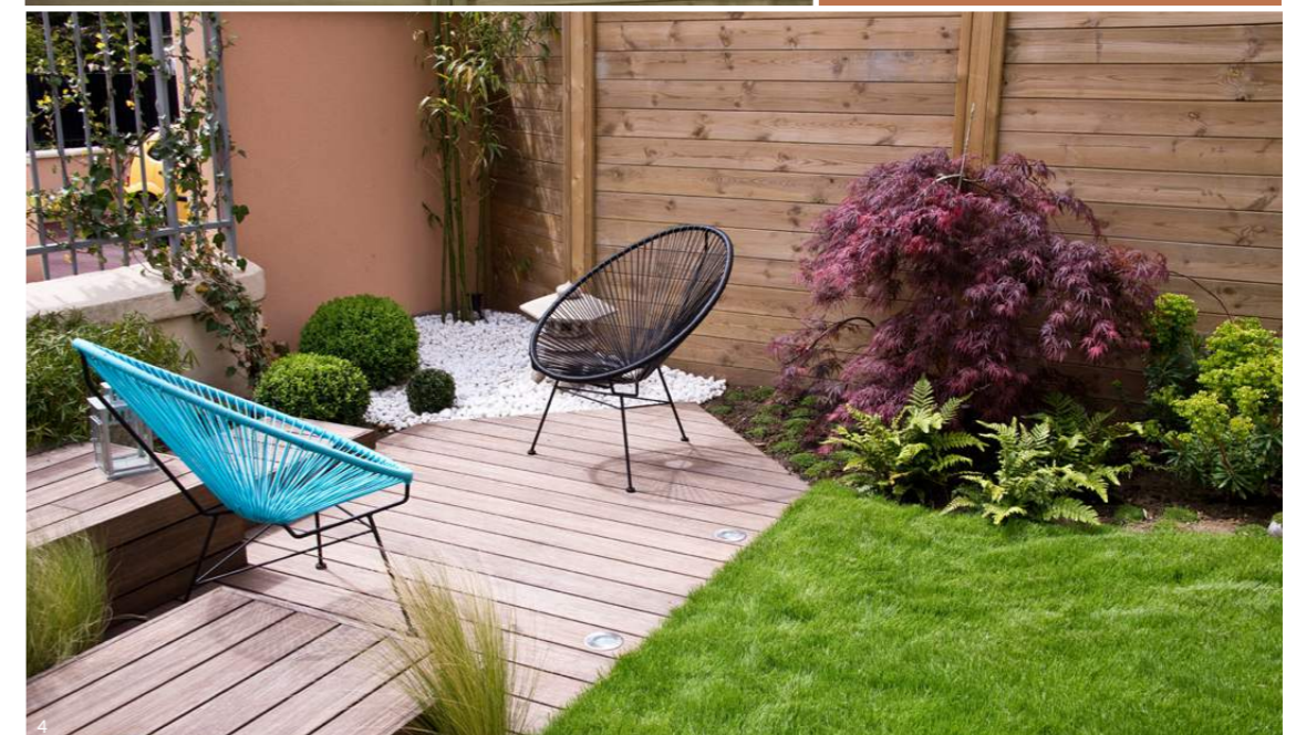
1, 2 et 3. Préservation verte / 4. Préservation marron 1, 2, 3, 4. Lames 28x135, poteaux 45x90, lame de finition 28x70
