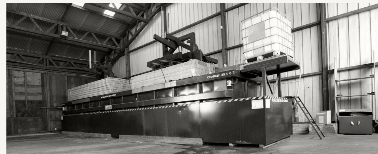
Bac de préservation Classe 2 - Site de Bouguenais (44)
